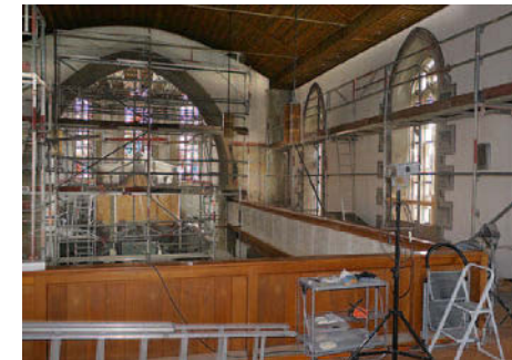
voll eingerüstet für die Wand-Maler
