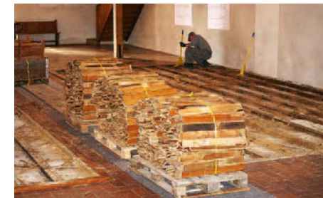
das Parkett wird entfernt
