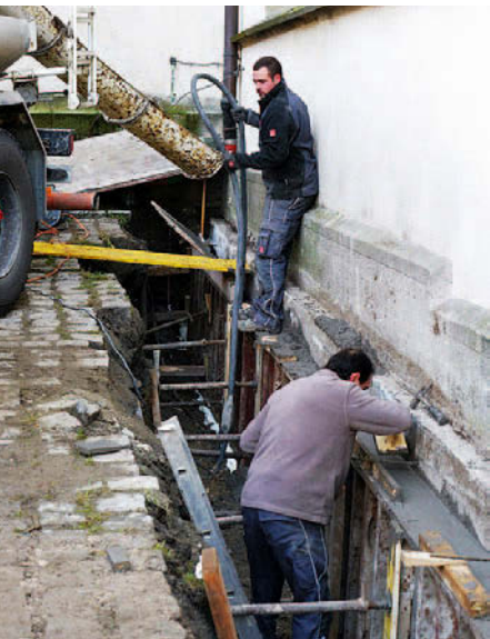
ein Streifenfundament wird angelegt
