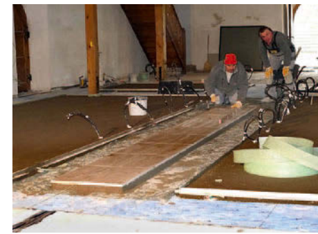
der neue Steinboden wird verlegt
