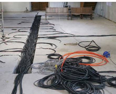
neue Kabel für Heizung, Licht, Akustik
