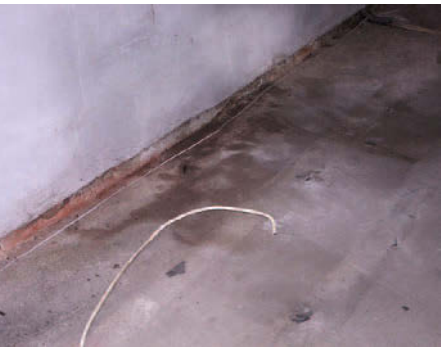
aufsteigende Nässe im Boden
