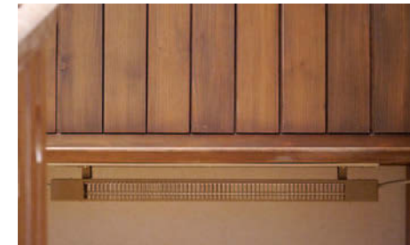
neue Heizkörper unter den Banksitzen
