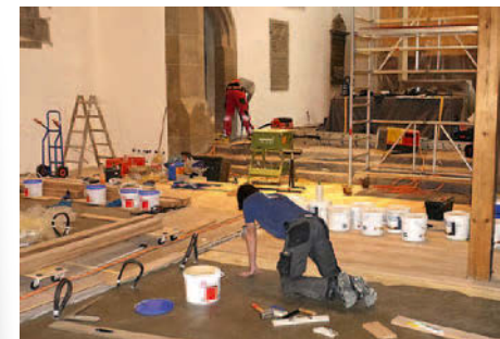
das neue Parkett im Bankbereich wird verlegt
