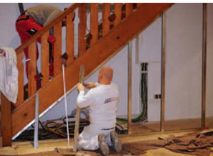
Stauraum unter Emporentreppen wird montiert
