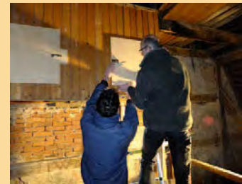
beim Umbau Tür zum „Falkenabteil“
