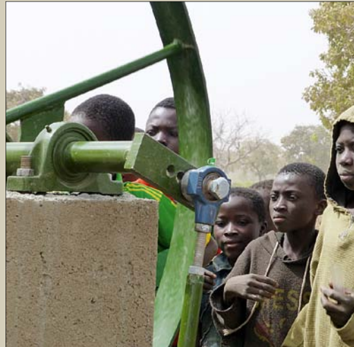
am Schwungrad einer neuen Wasserpumpe
