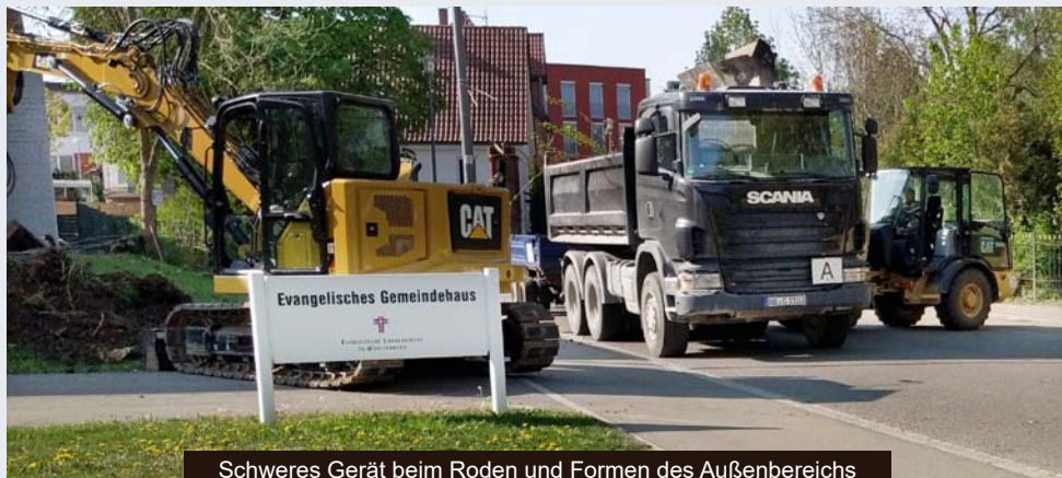
Schweres Gerät beim Roden und Formen des Außenbereichs
